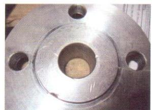
Рис. 2. Многочисленные забоины на зеркале фланца
